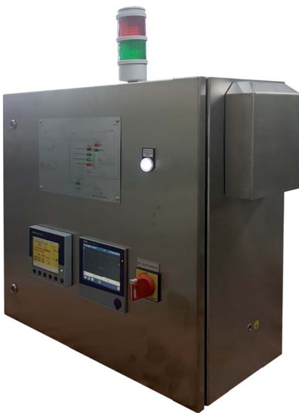
Schaltkasten mit "JUMO IMAGO 500" und JUMO "LOGOSCREEN 600"
