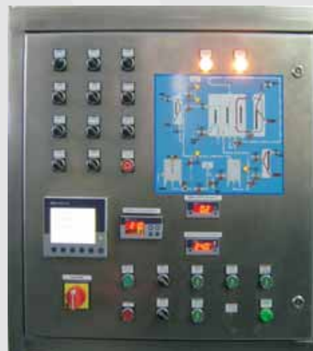
Система за контрол и управление на производствен цикъл в предприятието за млекопреработка Control and management system for the production process in dairying businesses
