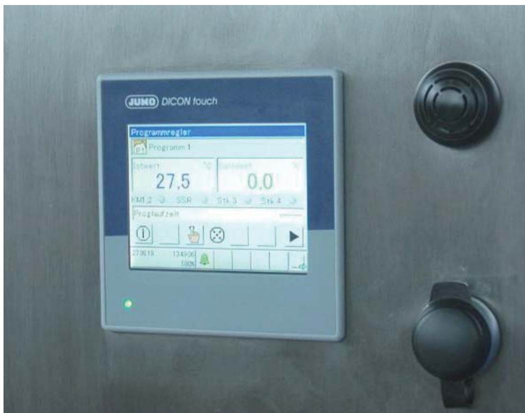
Строительная панель - уровень оператора
